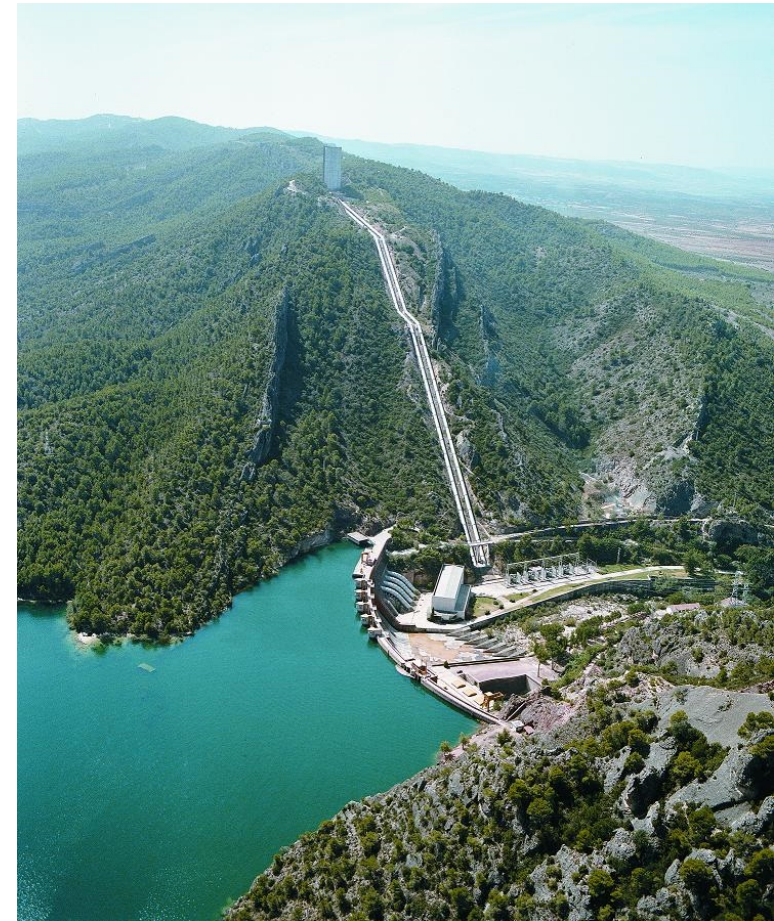
Zona de inicio del trasvase tajo-segura
